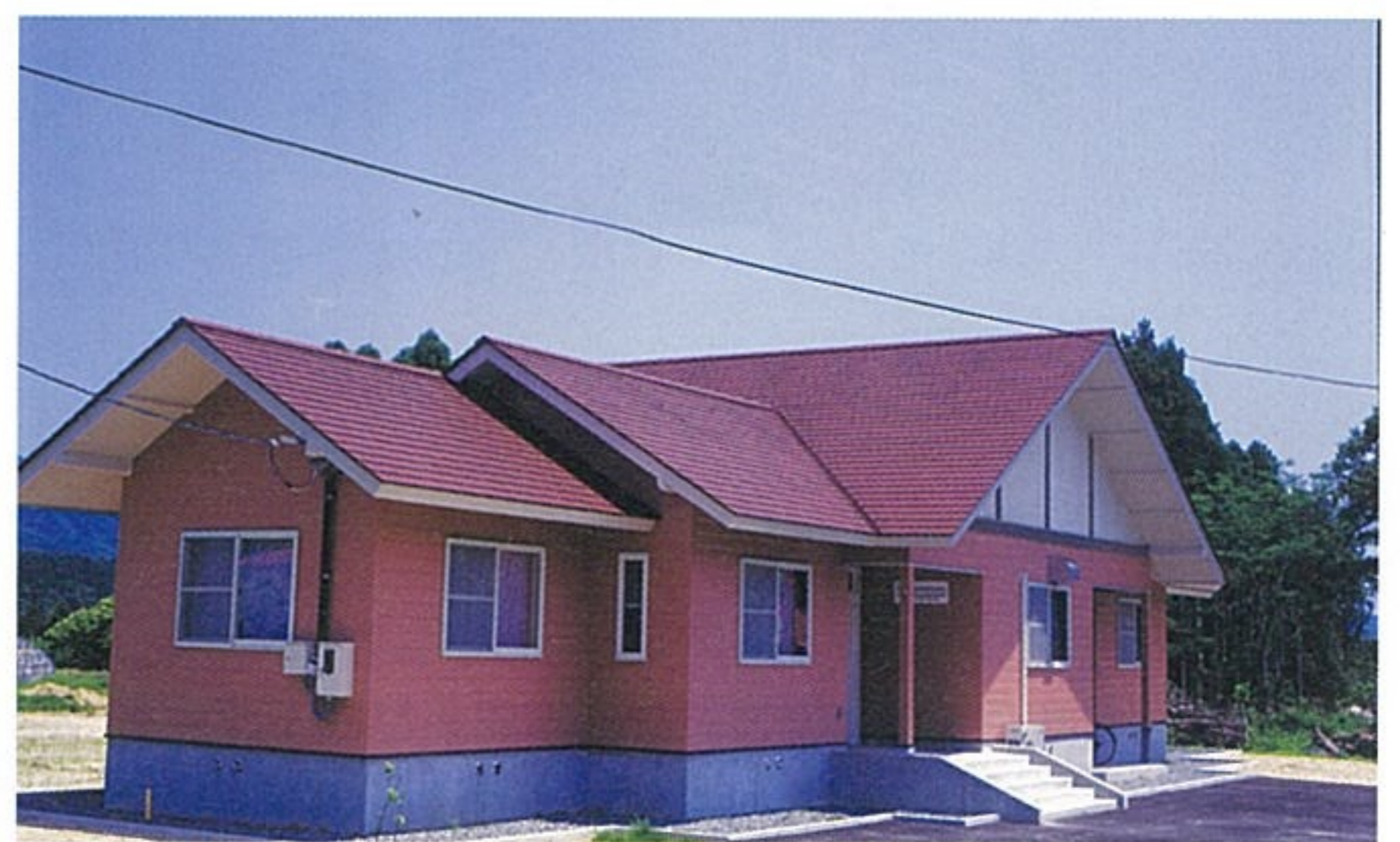
ヘルパー研修宿泊施設新築（平成8年10月）
