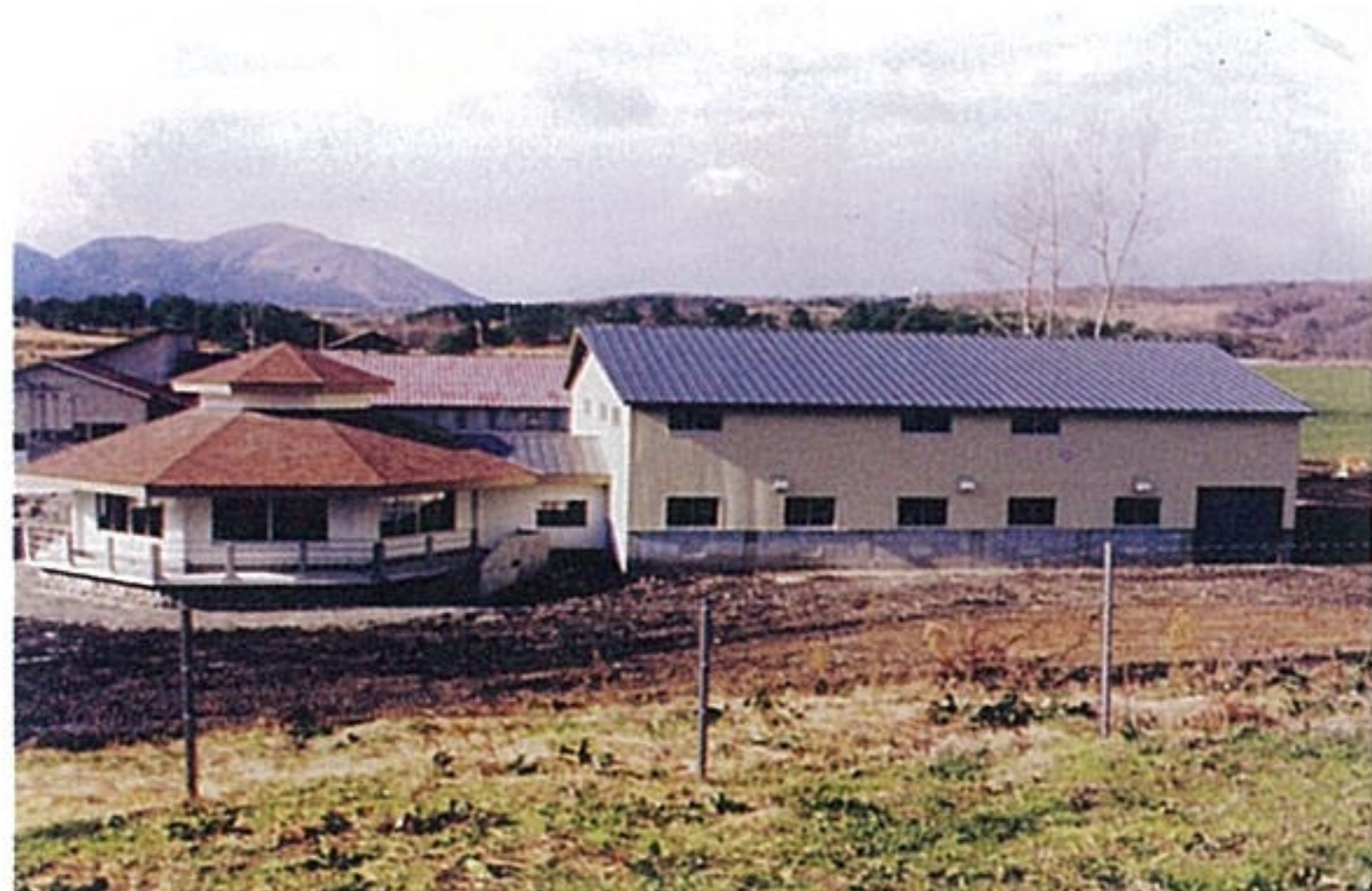
ロータリーパーラー完成（昭和53年）
