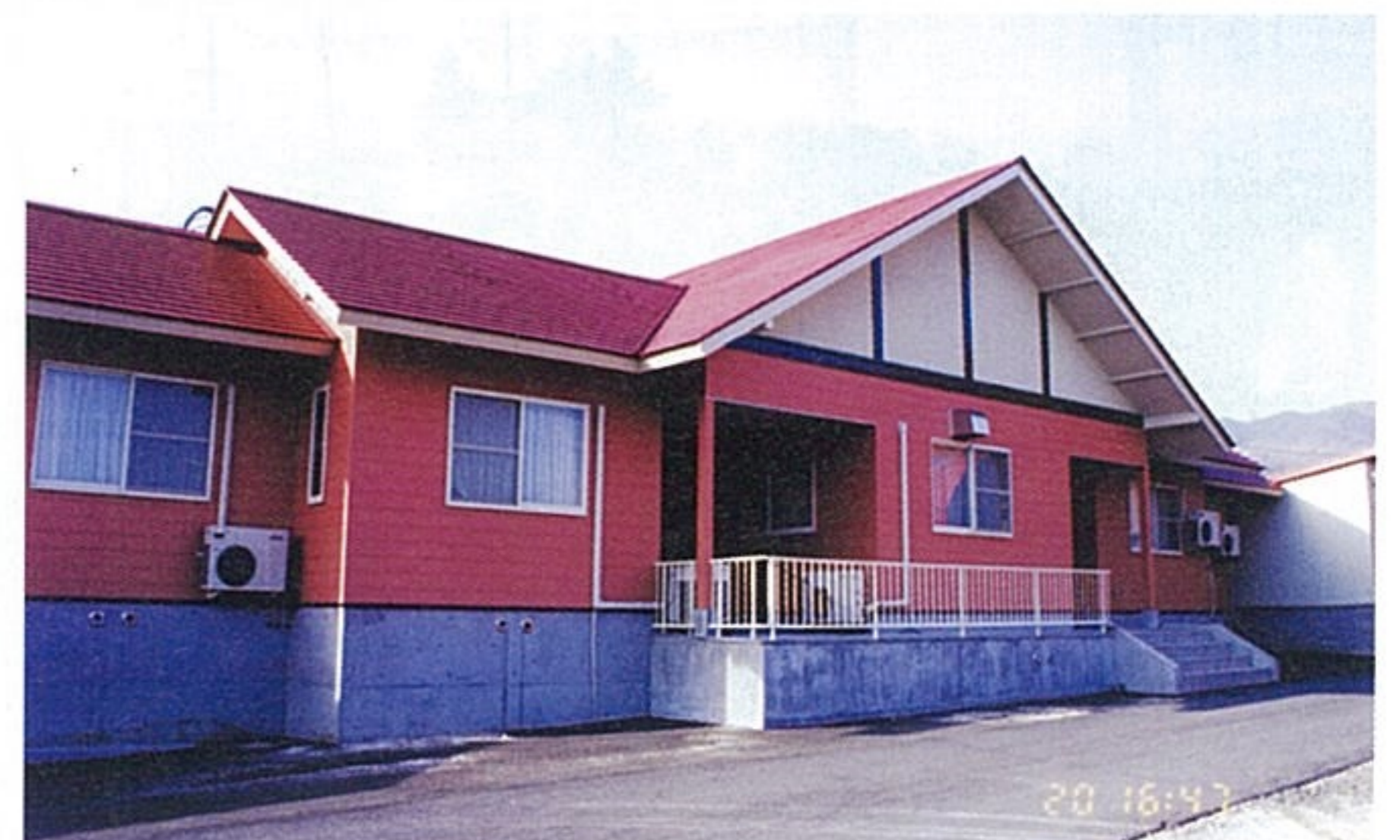
第2牧場研修生滞在施設新築（平成8年）
