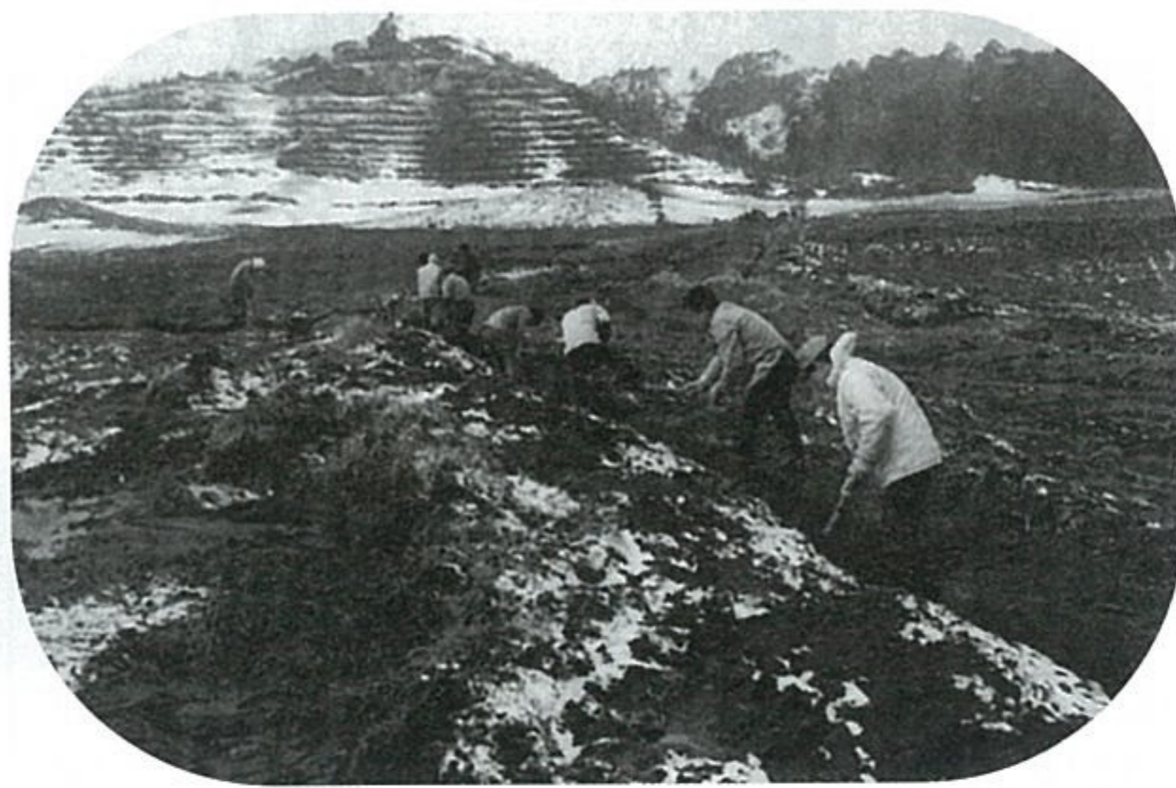
排水溝作業（昭和39年）
