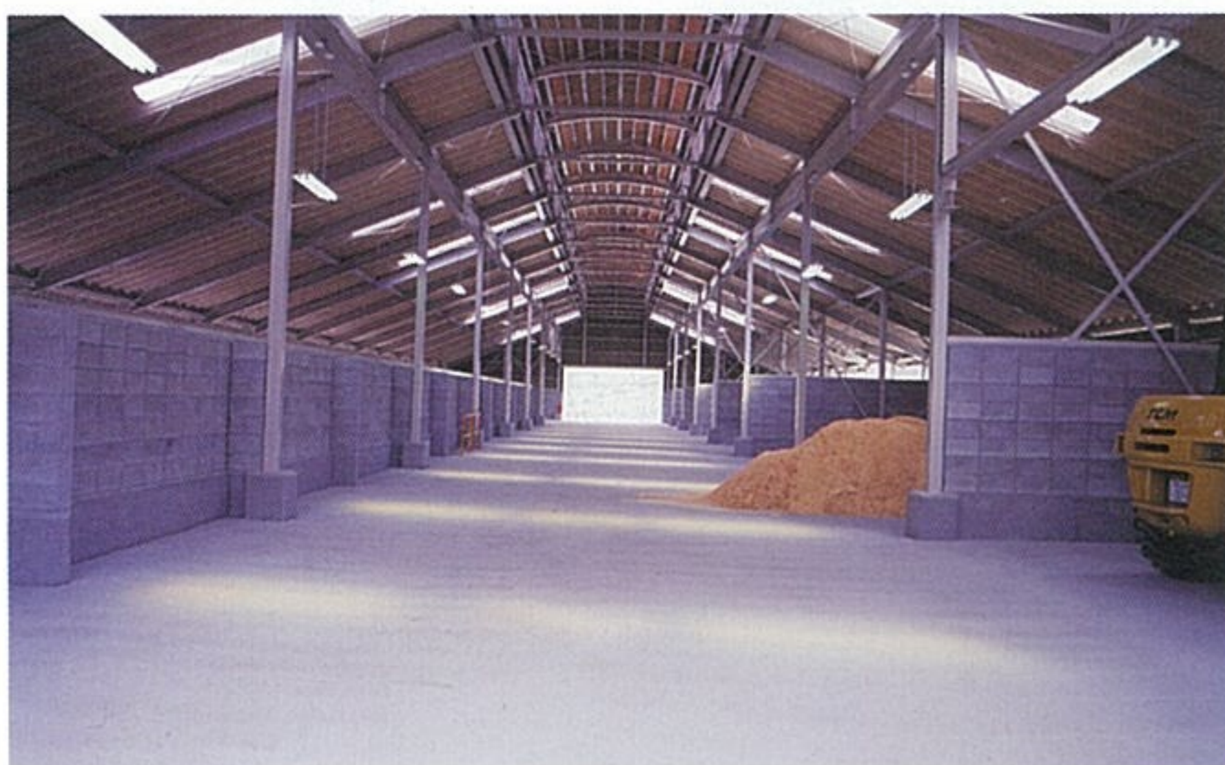
第2牧場堆肥舎新築（平成9年）
