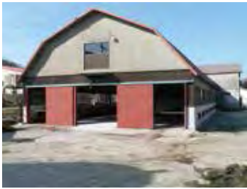
第 1 牧場旧搾乳牛舎を 乾乳牛舎へ改装(平成 19 年 3 月)
