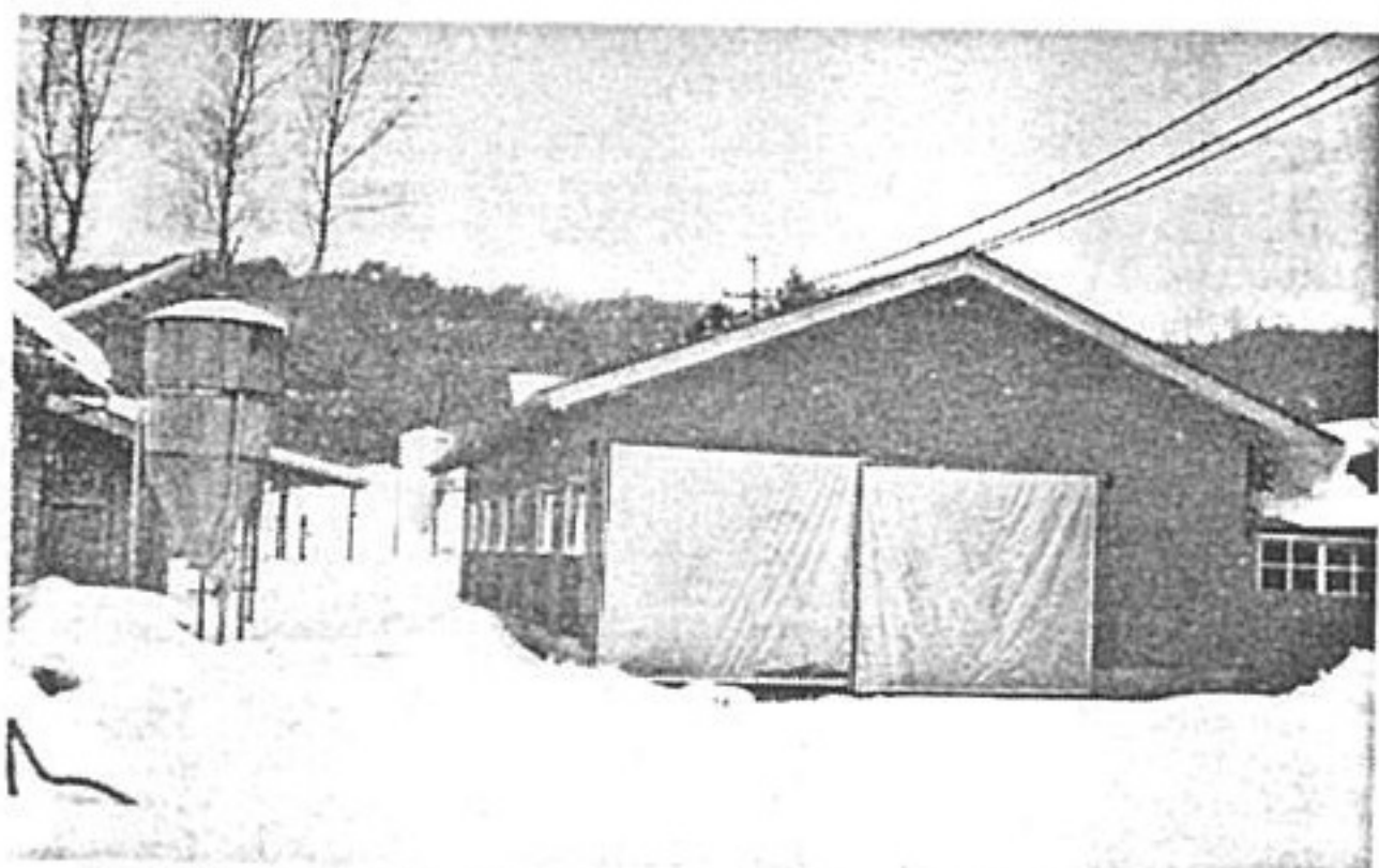
旧学生寮跡に建てられた木造牛舎
