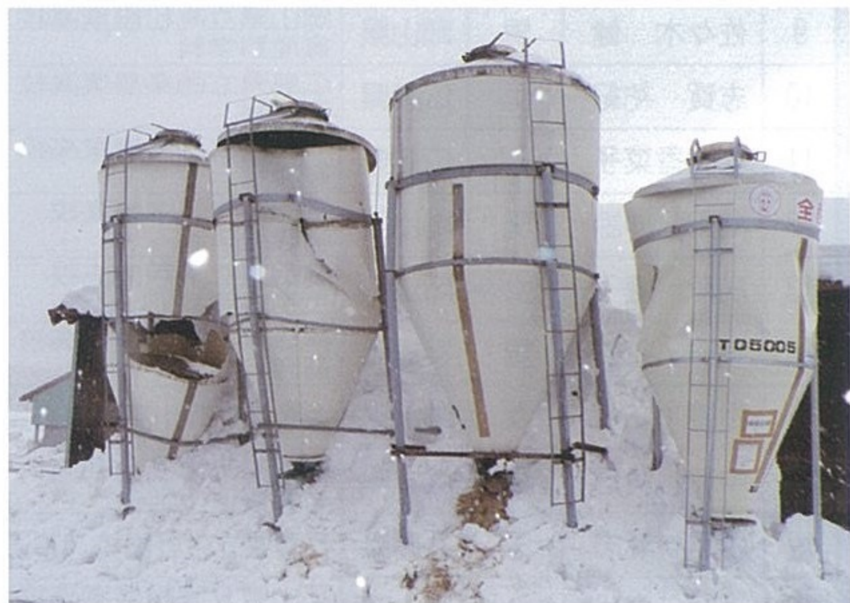
豪雪で倒壊した飼料タンク
